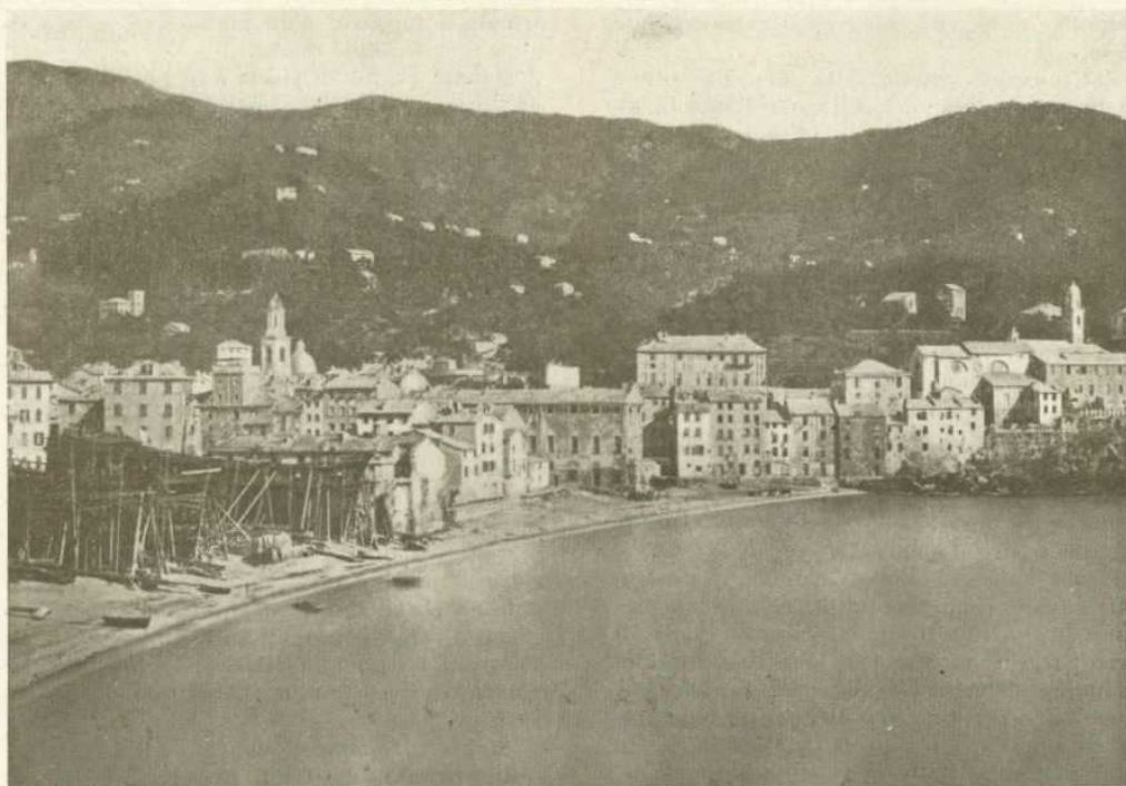
Recco col suo Cantiere.
